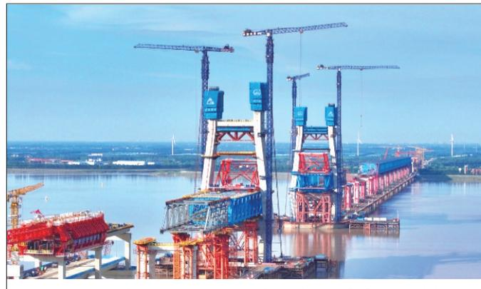
11日,崇启公铁长江大桥4号主塔顺利完成第六节钢梁吊装,塔身高度已达136米。 记者吴霄云 通讯员李梦竹
